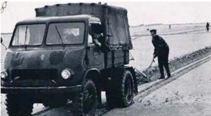
Einpflügen von Nitropentaschnur (Bild 8)
