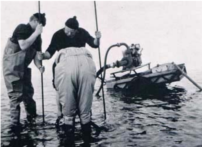
Spülbohrarbeiten mit Wattkarren (Bild 6)
