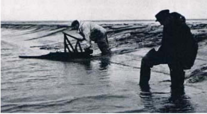
Transport des Bohrgerätes mit Wattschlitten (Bild 7)
