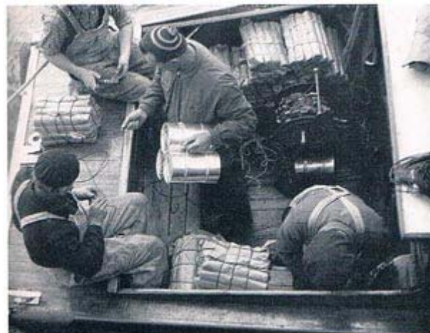
Die „Patronen“ werden gebündelt und an „Schwimmern“ aufgehängt
