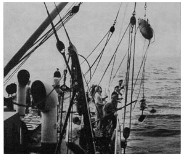
Das „Empfangssystem“ – bestehend aus Schwimmboje, Hydrophon und Beschwerung – wird zu Wasser gelassen
