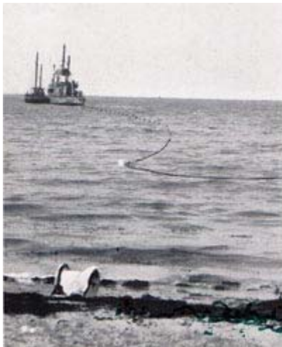
Das Kabel wird an Land gezogen
