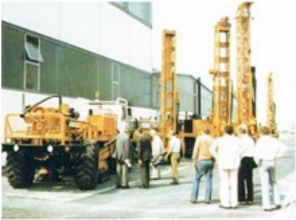
Gelände-Vibrator und Bohrergeräte verschiedener Typen auf dem Werksgelände in Uetze All-terrain vibrator and drilling rigs of different types at the site in Uetze
