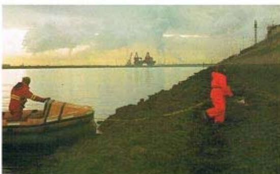
Landung an der Mole. Die Landanschlüsse werden hergestellt. A land connection being made
