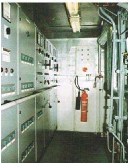
◀ Elektrische Verteilungs-Schalttafel Electrical distribution switchboard
