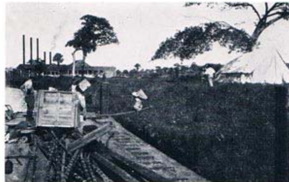
Sprengstoffübernahme. Rechts das Lagerzelt Dynamite transfer. Store tent on the right
