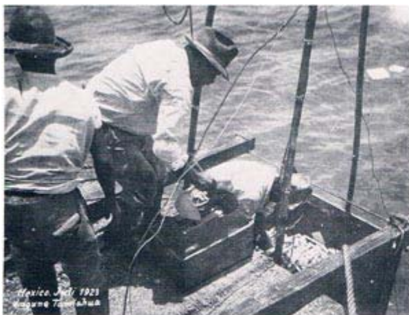
Die Sprengstoffkiste wird besetzt The dynamite crate being loaded
