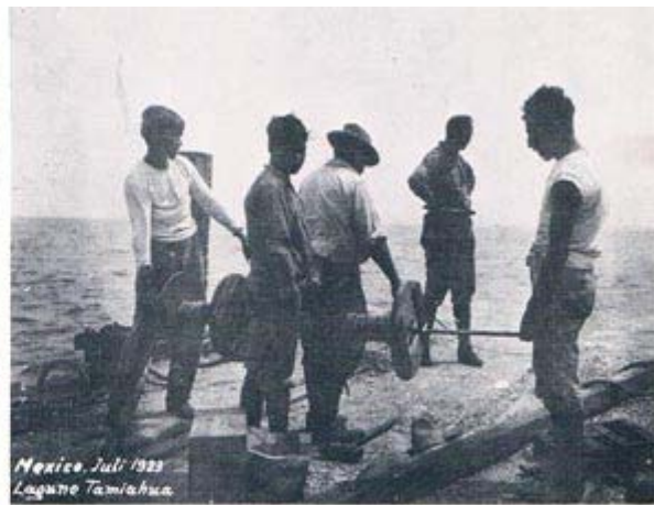
Das Sprengkabel wird abgerollt The shooting cable being rolled out
