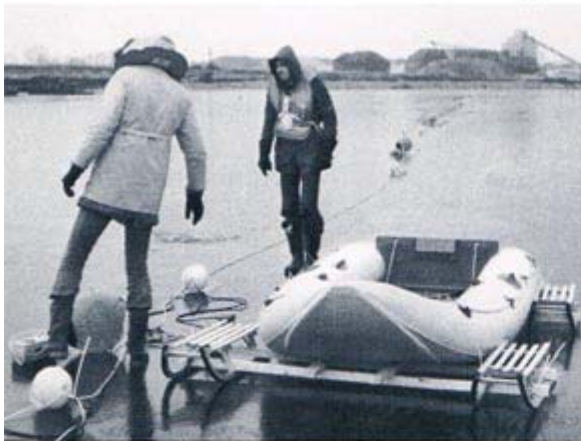
Geophonauslage über einem zugefrorenen Baggersee. Transportvehikel und Markierungsbojen Geophone layout crossing a gravel lake. Transport vehicle and marker buoys
