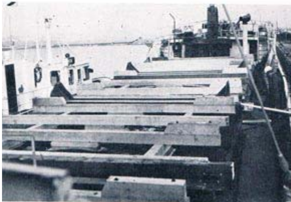
Verladung des Meßschiffs „Ingrid“ auf das Mutterschiff in Bremerhaven. Links im Bild der Unterbau an Deck der Gesine H auf dem die Ingrid vertäut wird
