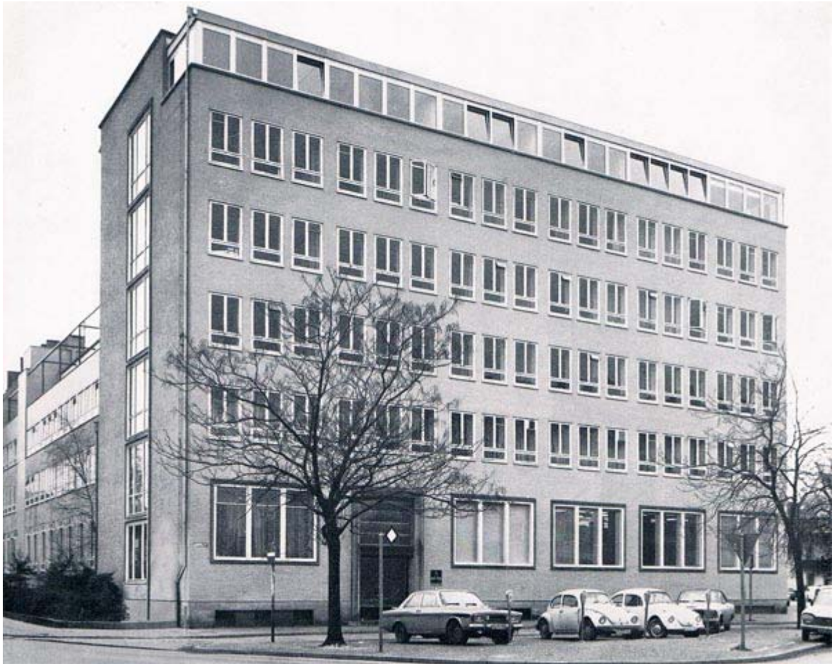
Teilansicht des PRAKLA-SEISMOS-Datenzentrums, Hannover Wiesenstraße 1
